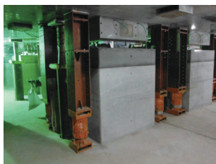
写真② 免震基礎が構築され、免震装置が据付。この後、仮の支柱が撤去される。
