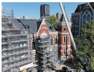
写真③ 外壁と屋根の改修工事
