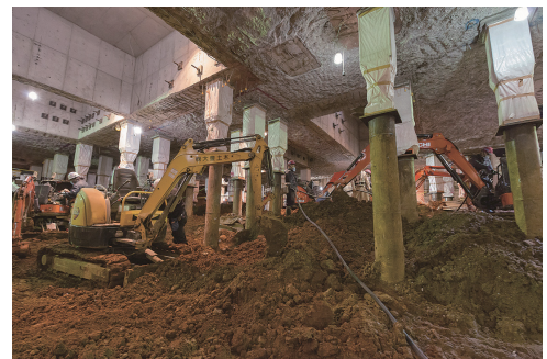
写真① 地下からは大量の土が掘削された
